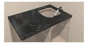
Fig. 1.4.47: Sealing counter top
