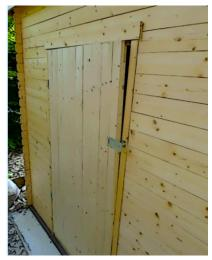
Fig. 15.3.4.1: Warped door
